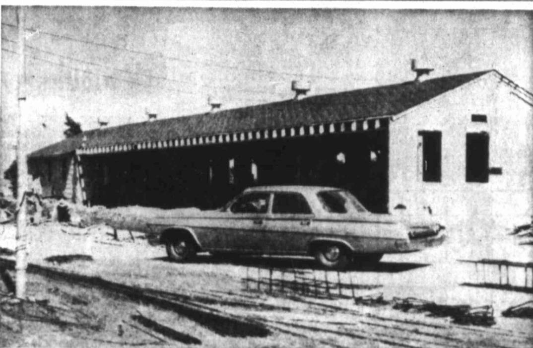
Getting Ready To Pour Concrete
