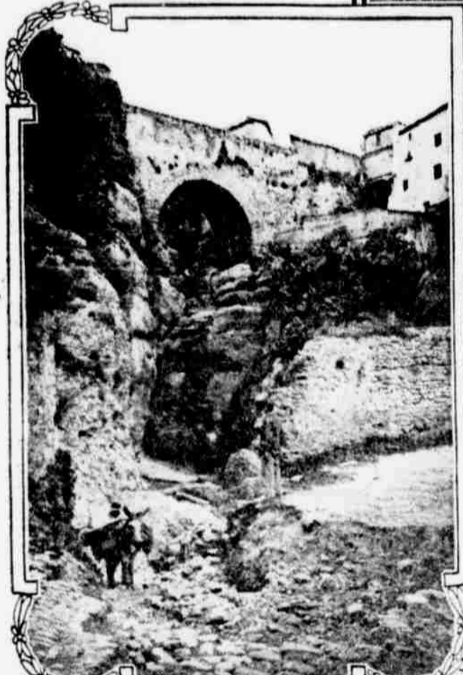
PUENTE DE SAN MIGUEL, RONDA
