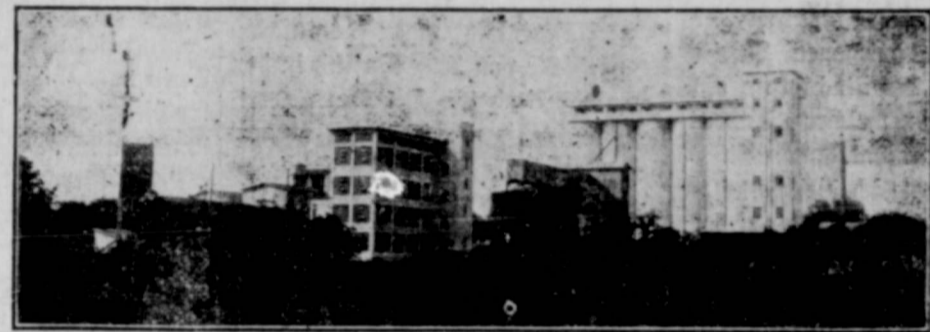
Mühlenanlage und Elevator der Dittlinger Roller Mills Co., Neu-Braunfels.
