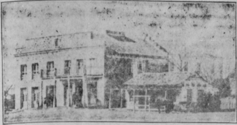
Schmitz' Hotel (später Guadalupe Hotel, jetzt Plaza Hotel), Südwestecke der Plaza, während des Bürgerkrieges.
