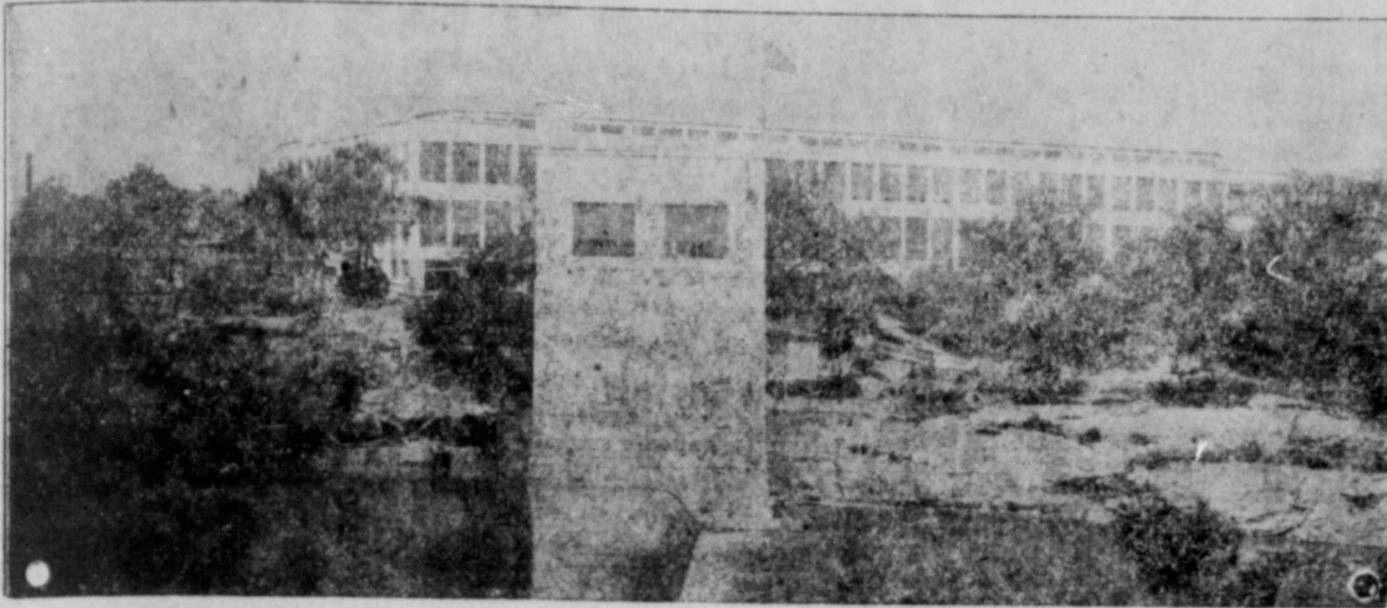
Ginghamfabrik und Kraftstation der Planters & Merchants Mills, Neu-Braunfels.
