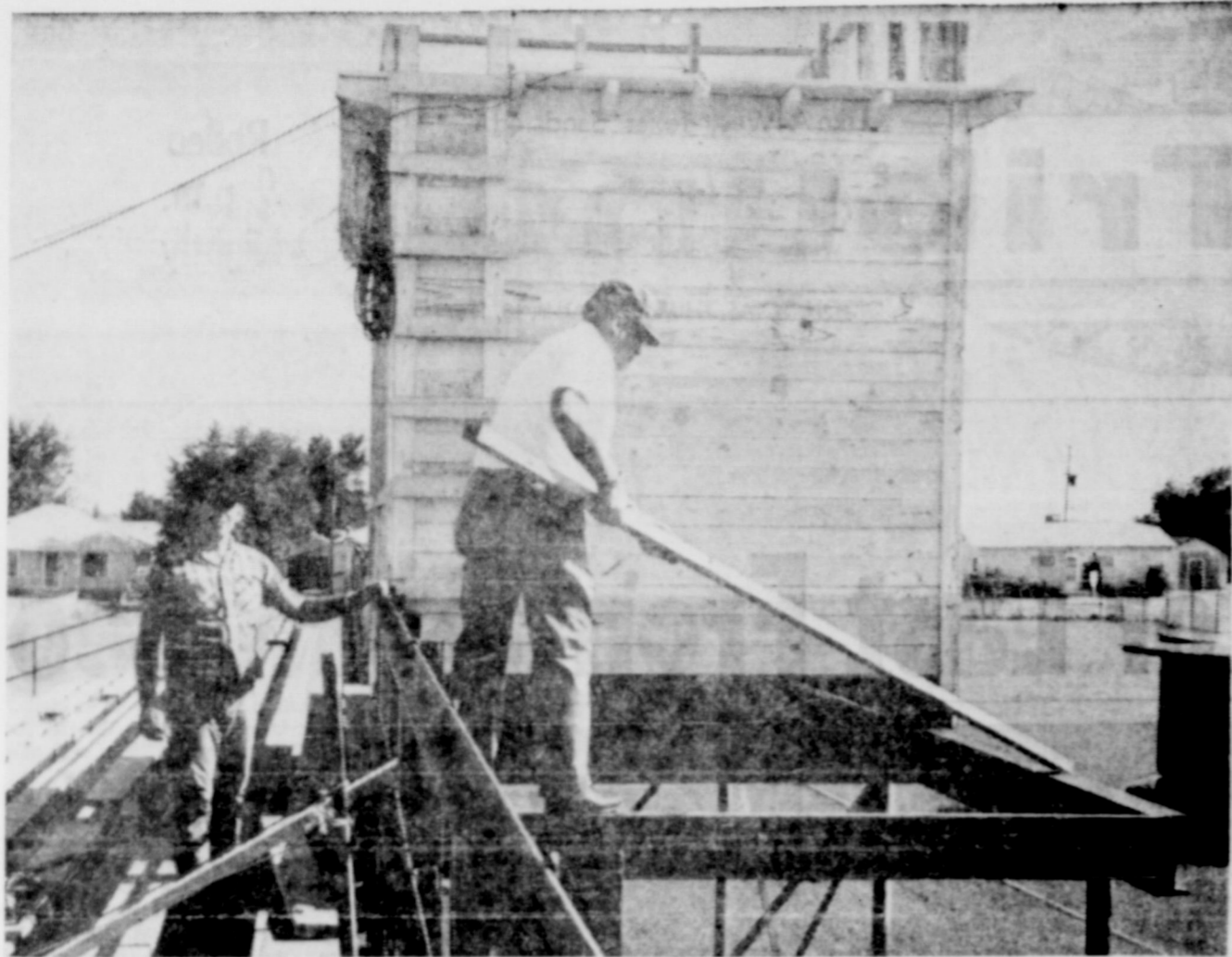
Press box construction . . .
