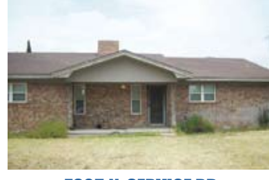
7605 N. SERVICE RD.
