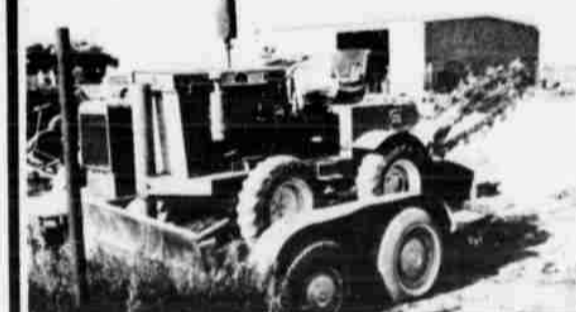
V-30 DITCH WITCH
